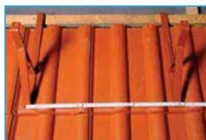
Obr. 2 - Max. rozteč držáků
