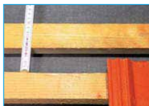
Obr. 1 - Poloha mezilatě pro montáž držáků
