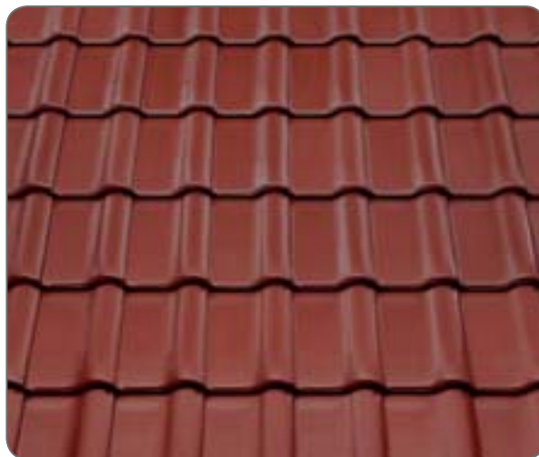
pokládka na stříh
