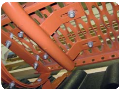
Obr. 13 Připevnění stojek zábradlí pomocí čtyř šroubů
