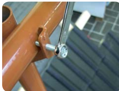
Obr. 15 Upevnění vodorov- ných tyčí zábradlí
