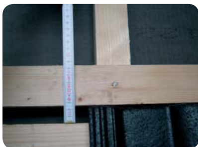
Obr. 1 Vzdálenost mezilatě 85 mm
