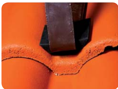
Obr. 2 Nasazení pryžové podložky u Římské tašky
