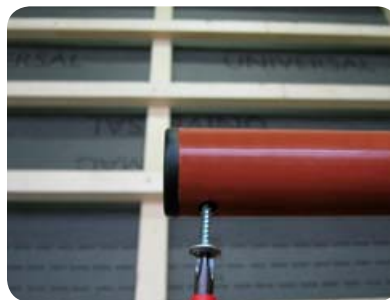
Obr. 16 Krytky a jejich zajištění
