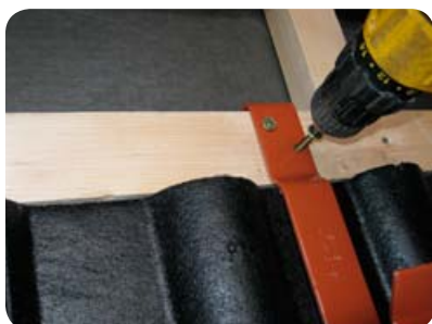
Obr. 3 Upevnění háku k mezilati
