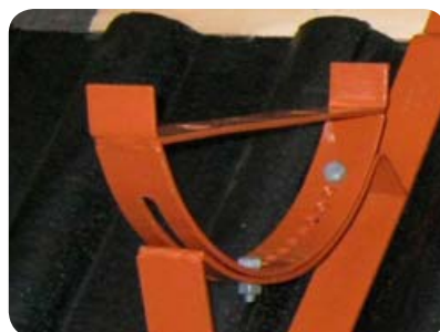
Obr. 5 Upevnění držáku do závěsného háku
