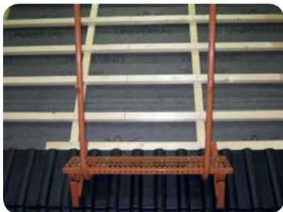
Obr. 12 Připevnění stojek zábradlí
