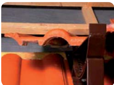
Obr. 7 Drážka v tašce pro překrytí háku
