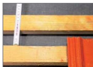
Obr. 1 - Poloha mezilatě pro montáž držáků
