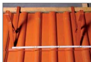
Obr. 2 - Max. rozteč držáků
