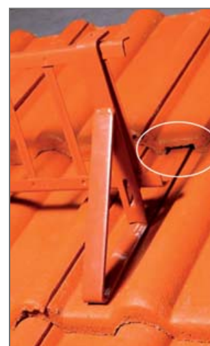
Obr. 3 - Vybroušená drážka
