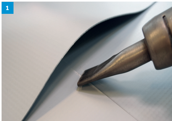
Obr. 15: Kontrola svaru izolačskou jehlou
