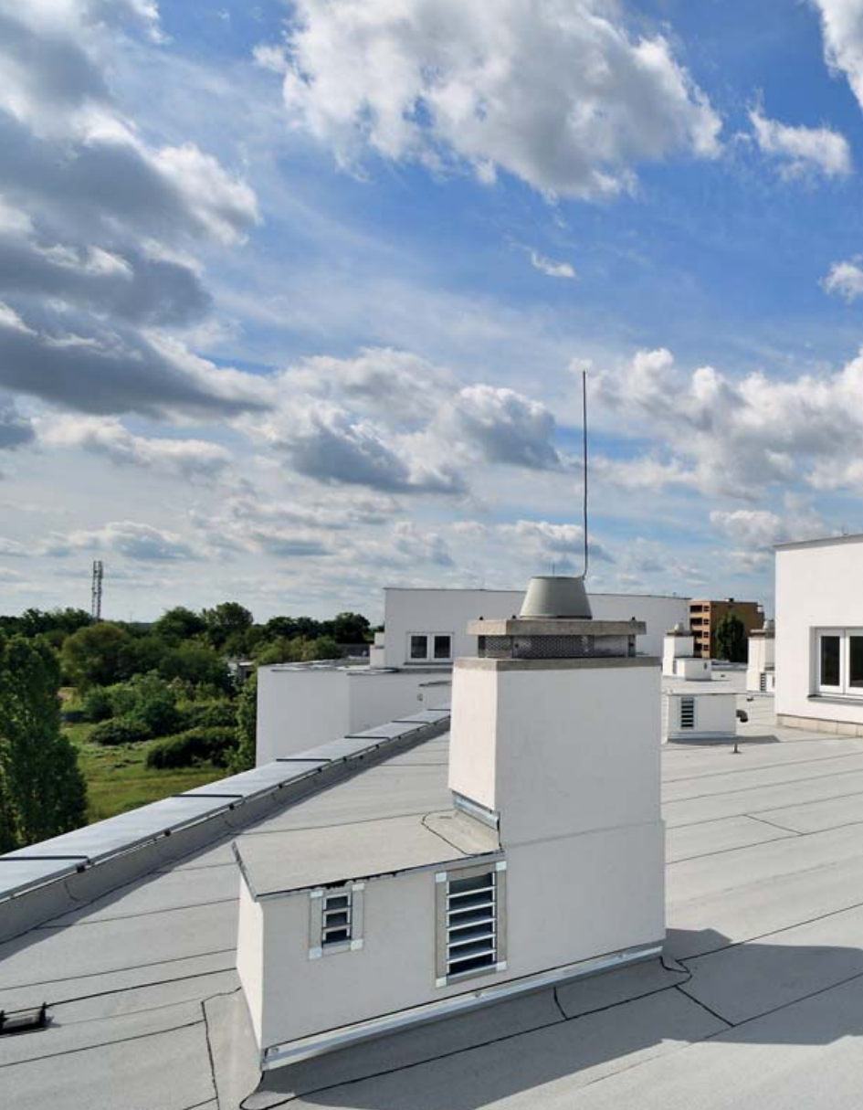
Bytový dům, Praha | Eco-Activ | 4.500 m 2
