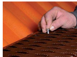
Obr. 5 - Připevnění stoupací plošiny
