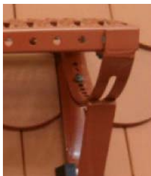
Tašky navazující na závěsný hák se podle potřeby upraví seříznutím v podélném směru.
