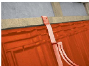
Obr. 8 - Připevnění závěsného háku
