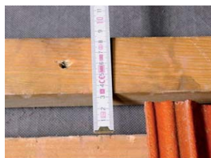
Obr. 1 - Poloha mezilatě pro zavěšení háku
